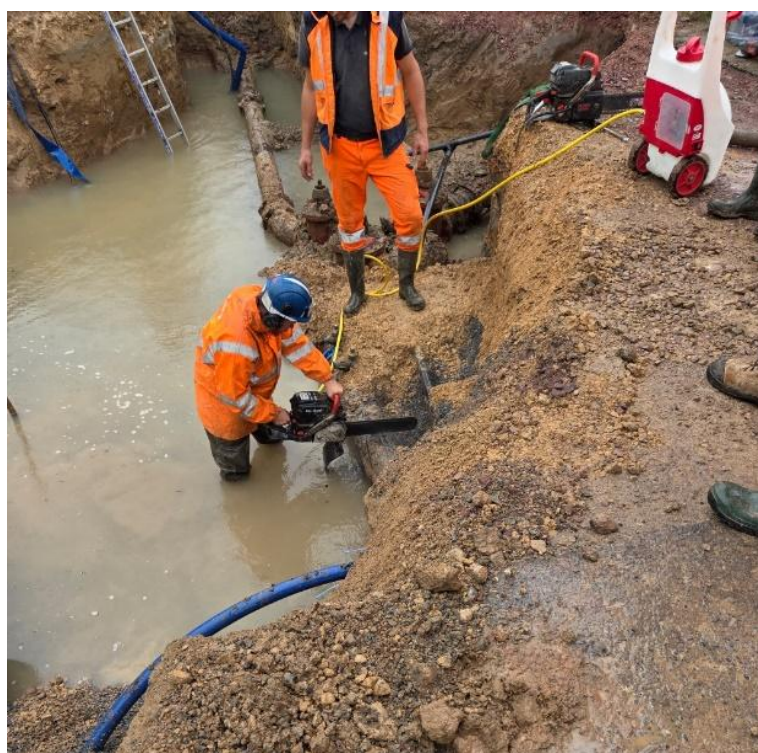
L'ancien réseau existant à enlever et ci-dessous la découpe tuyau à la tronçonneuse
