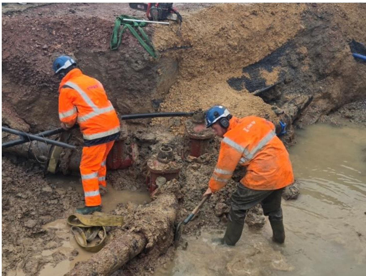
L'ancien réseau existant à enlever et ci-dessous la découpe tuyau à la tronçonneuse
