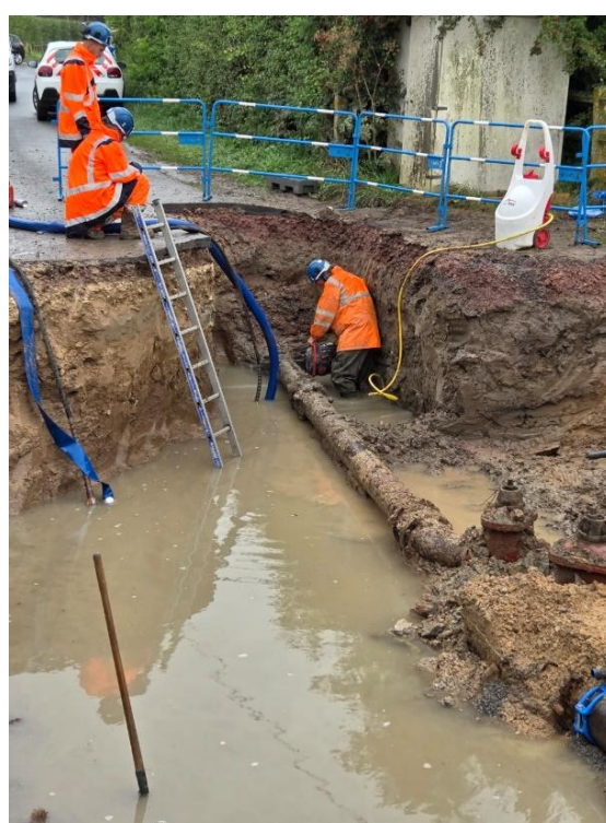
L'ancien réseau existant à enlever et ci-dessous la découpe tuyau à la tronçonneuse
