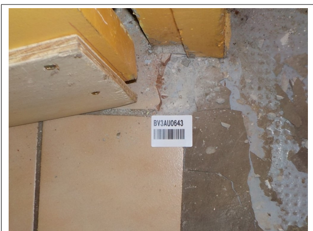
Prélèvement - PM17 : Cuisine - Colle- (Absence d'amiante)
