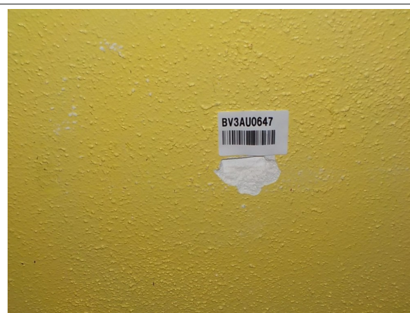
Prélèvement - PM21 : Stockage décors - Enduit- (Absence d'amiante)
