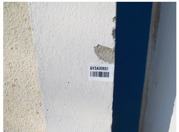
Prélèvement - PM25 : Extérieur - Enduit- (Absence d'amiante)
