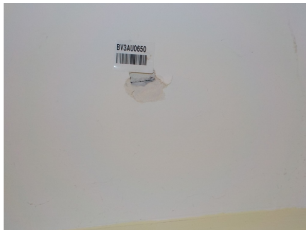
Prélèvement - PM24 : Couloir classes - Enduit- (Absence d'amiante)
