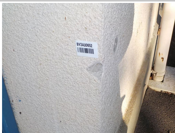
Prélèvement - PM26 : Extérieur - Enduit- (Absence d'amiante)
