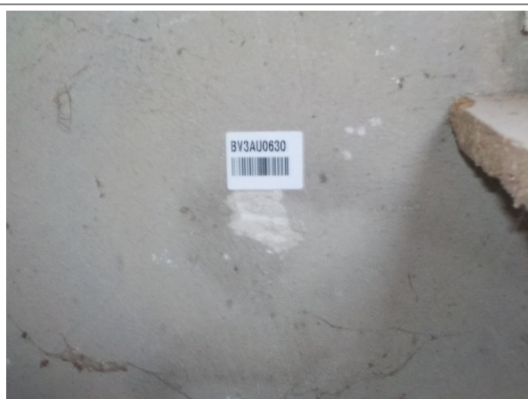
Prélèvement - PM4 : Garage et cave - Enduit- (Absence d'amiante)
