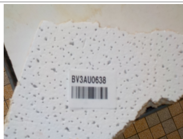
Prélèvement - PM12 : Classe 3 - Faux plafond- (Absence d'amiante)
