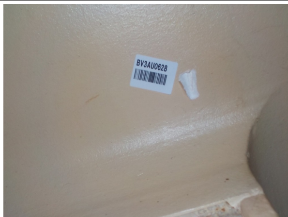
Prélèvement - PM2 : Logement de fonction > Chambre 2 - Enduit- (Absence d'amiante)
