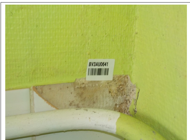
Prélèvement - PM15 : Cuisine - Colle- (Absence d'amiante)
