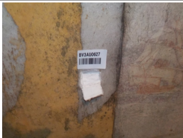
Prélèvement - PM1 : Logement de fonction > Chambre 2 - Enduit- (Absence d'amiante)
