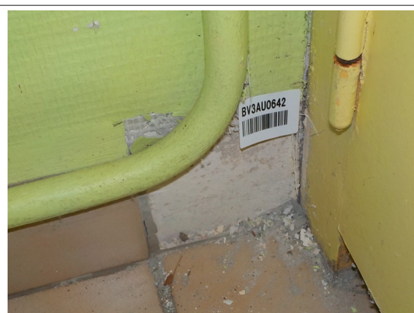
Prélèvement - PM16 : Cuisine - Colle- (Absence d'amiante)
