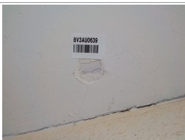
Prélèvement - PM13 : Couloir préau - Enduit- (Absence d'amiante)
