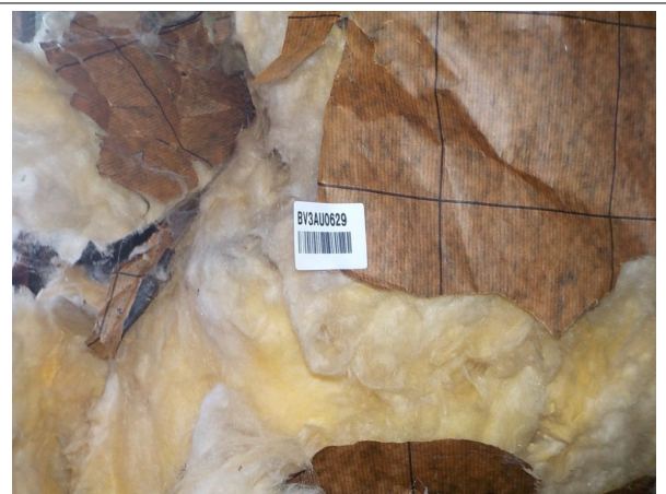
Prélèvement - PM3 : Logement de fonction > Combles - Isolant- (Absence d'amiante)
